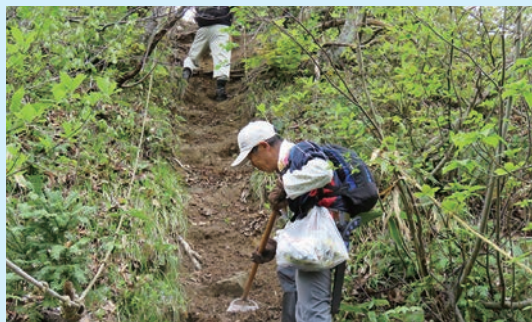
枯葉などを撤去し、階段を整備
