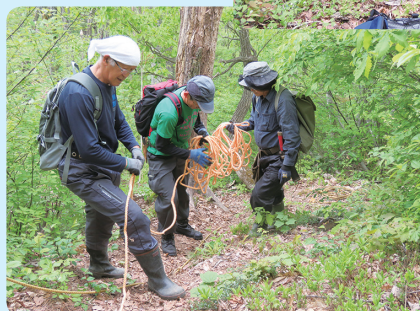
劣化したロープの 張替え
